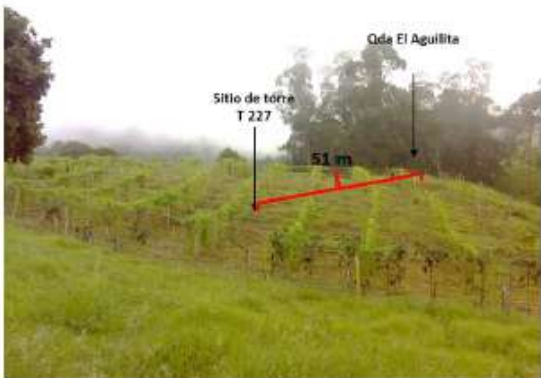
Figura 16. Sitio de torre T227 Vs Distancia a la Qda El Aguilita a 51m del sitio de torre Fuente: GEB, 05 de abril de 2018
